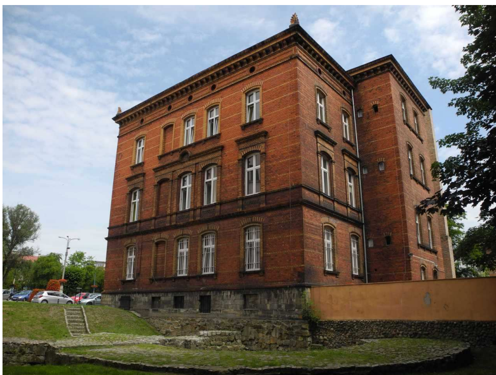
Fot. 2 elewacja boczna i tylna
