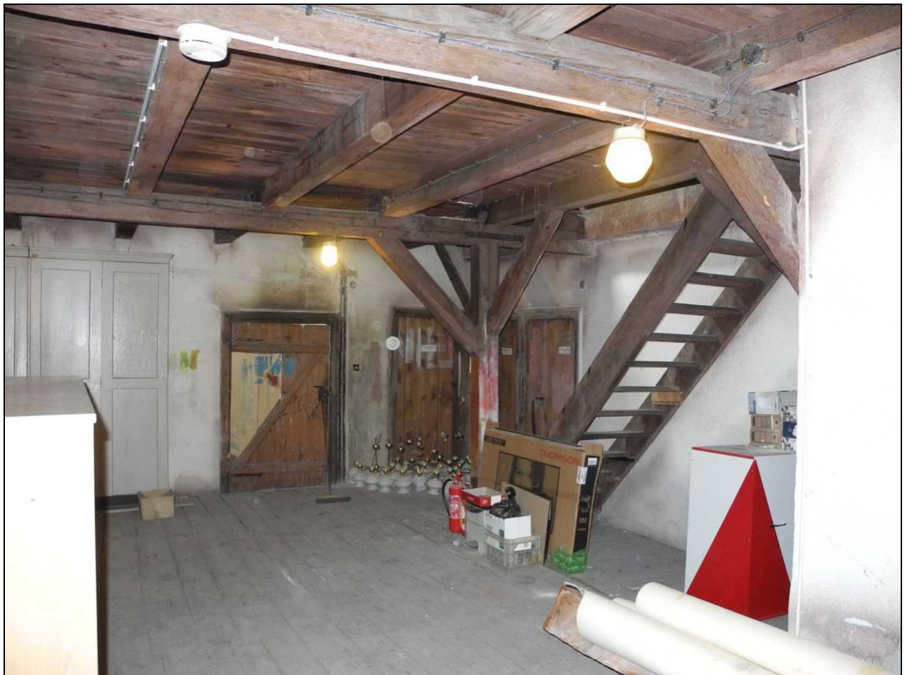
Fot. 19 strych poziom I
