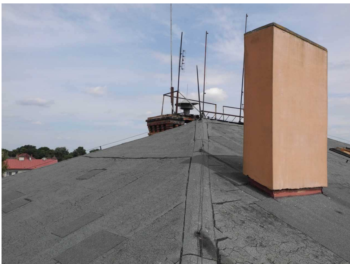
Fot. 7 dach – część południowo-zachodnia
