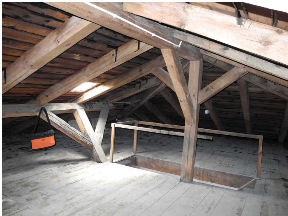
Fot. 15 strych – poziom II
