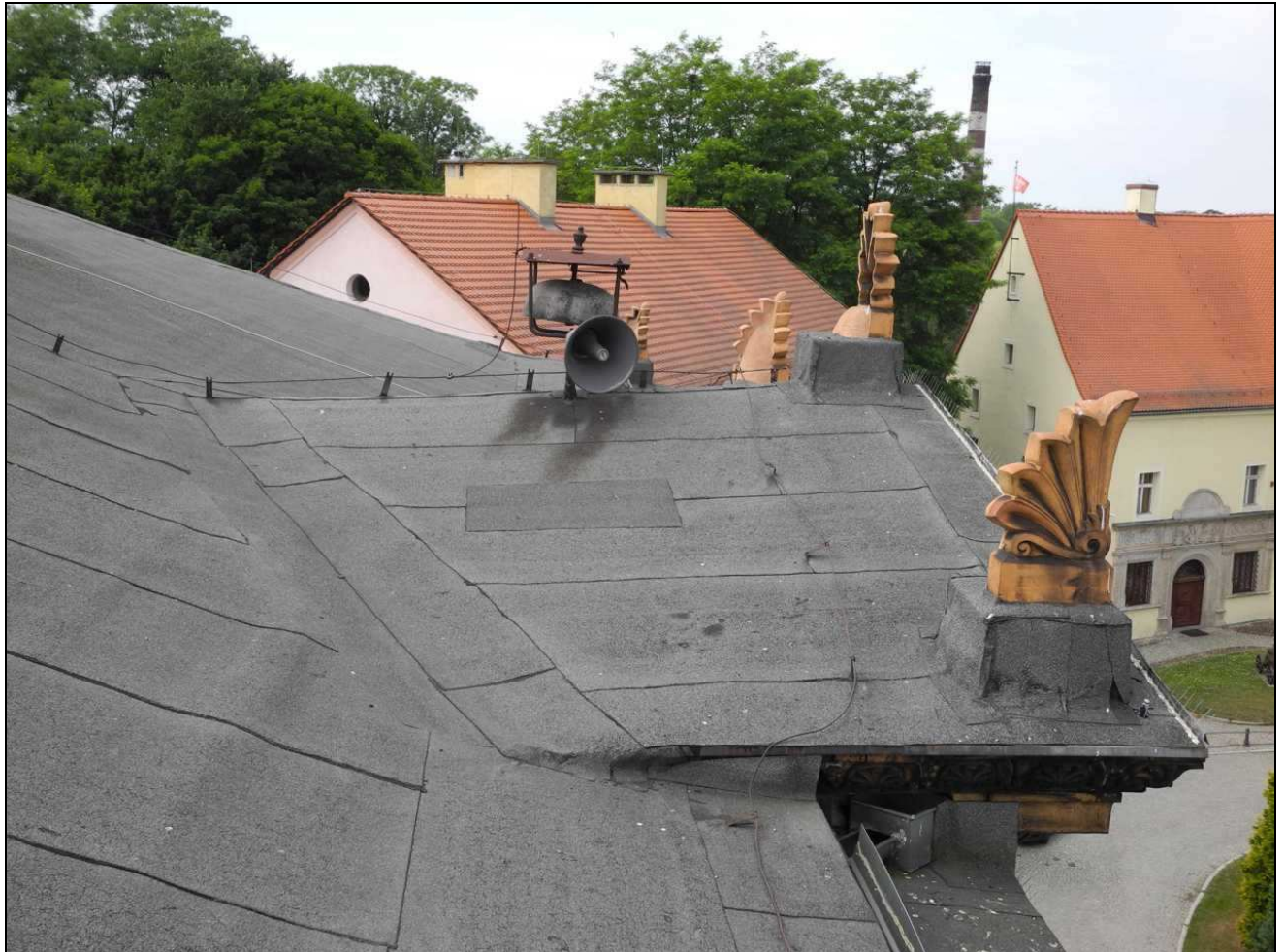
Fot. 8 dach – część środkowa od frontu
