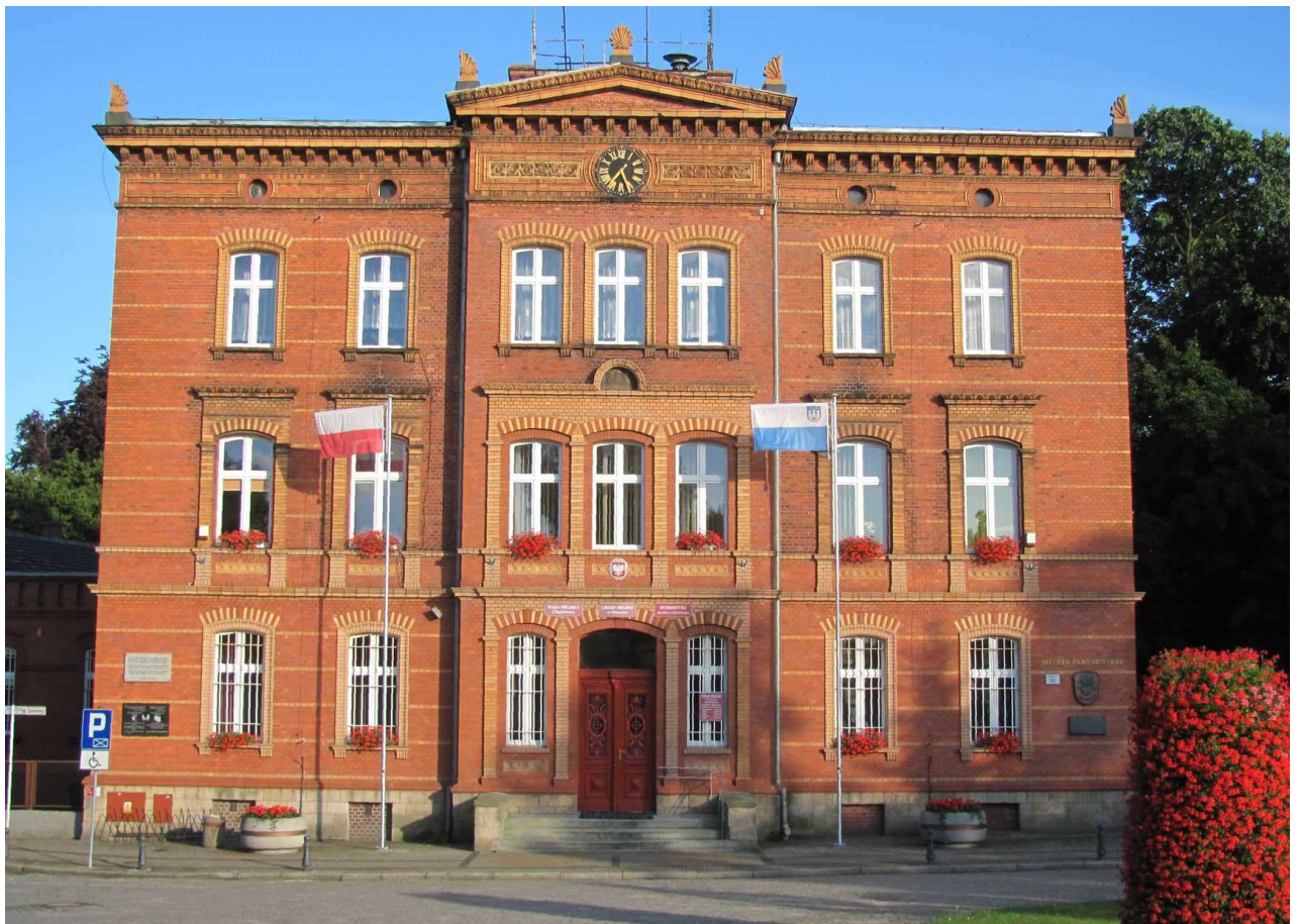
Fot. 1 elewacja frontowa
