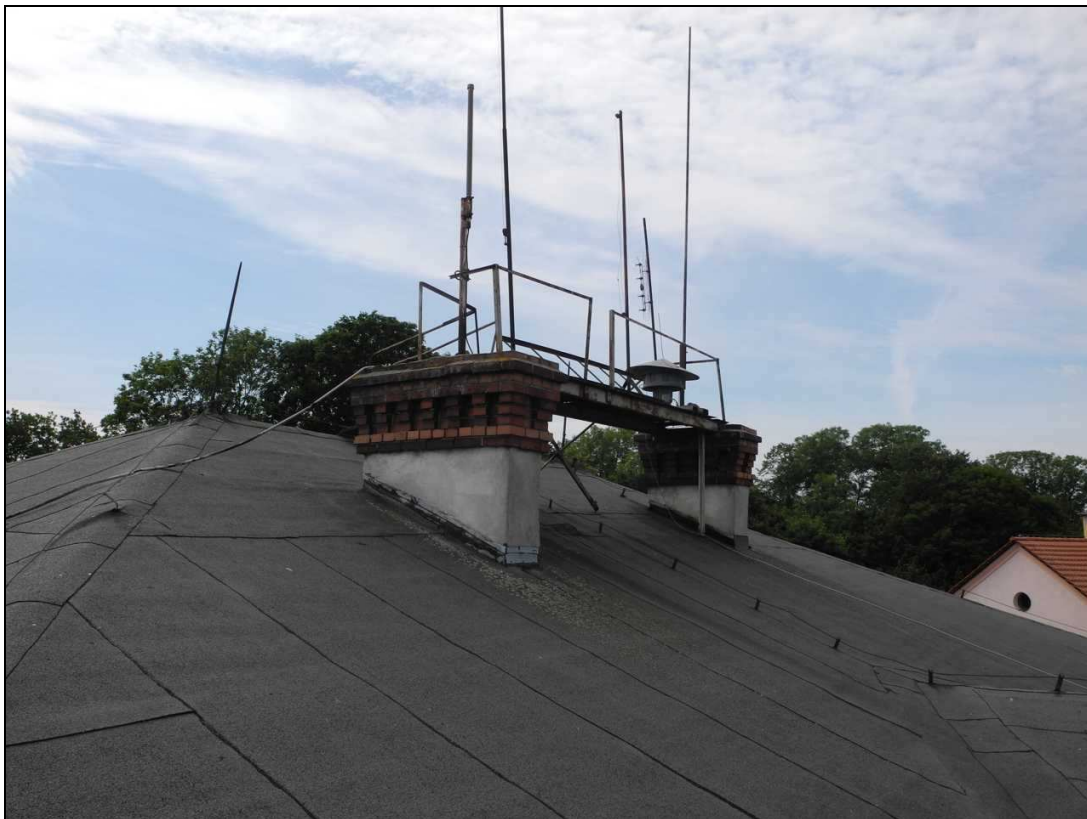
Fot. 11 pomost techniczny od frontu
