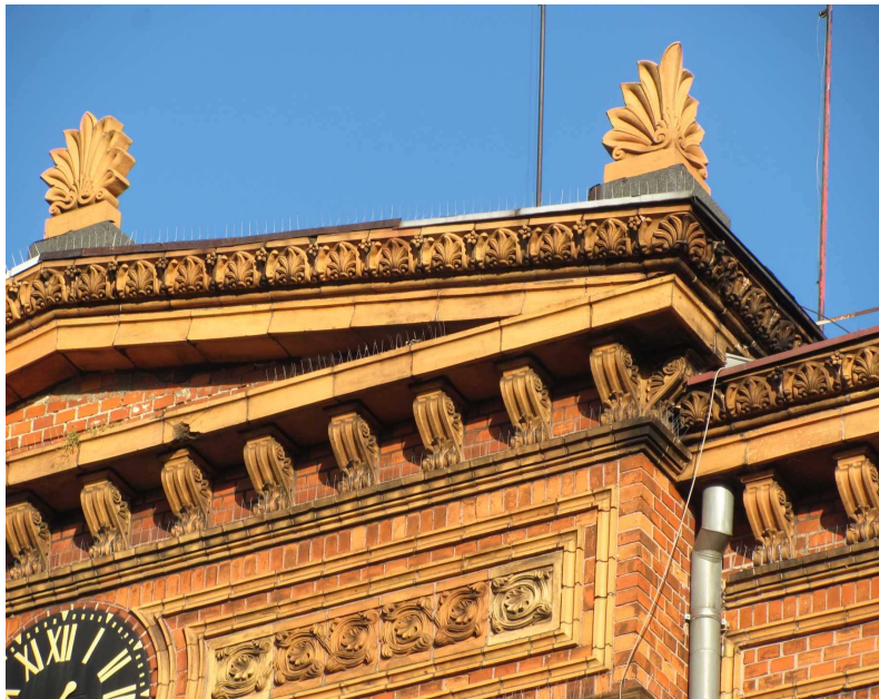
Fot. 4 elewacja frontowa – szczegóły
