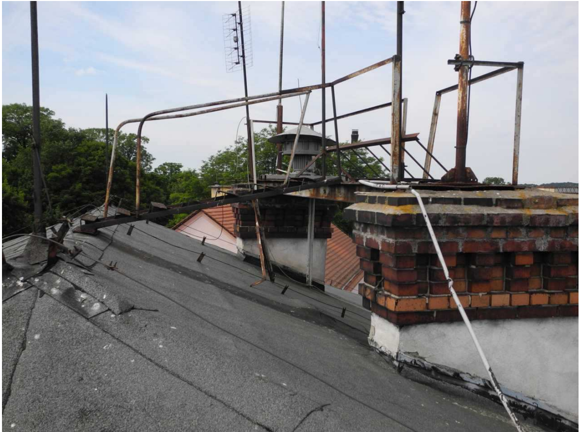
Fot. 10 pomost techniczny - szczegóły
