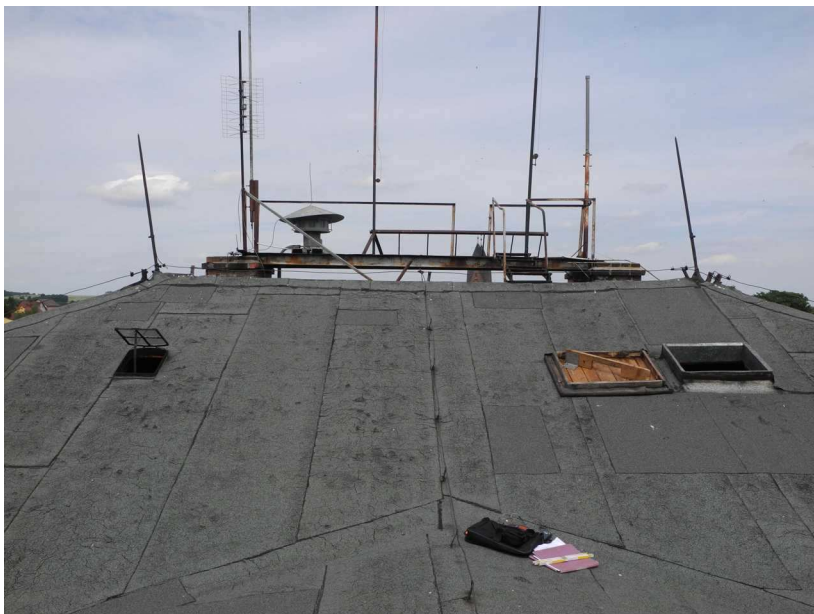
Fot. 9 dach – pomost techniczny
