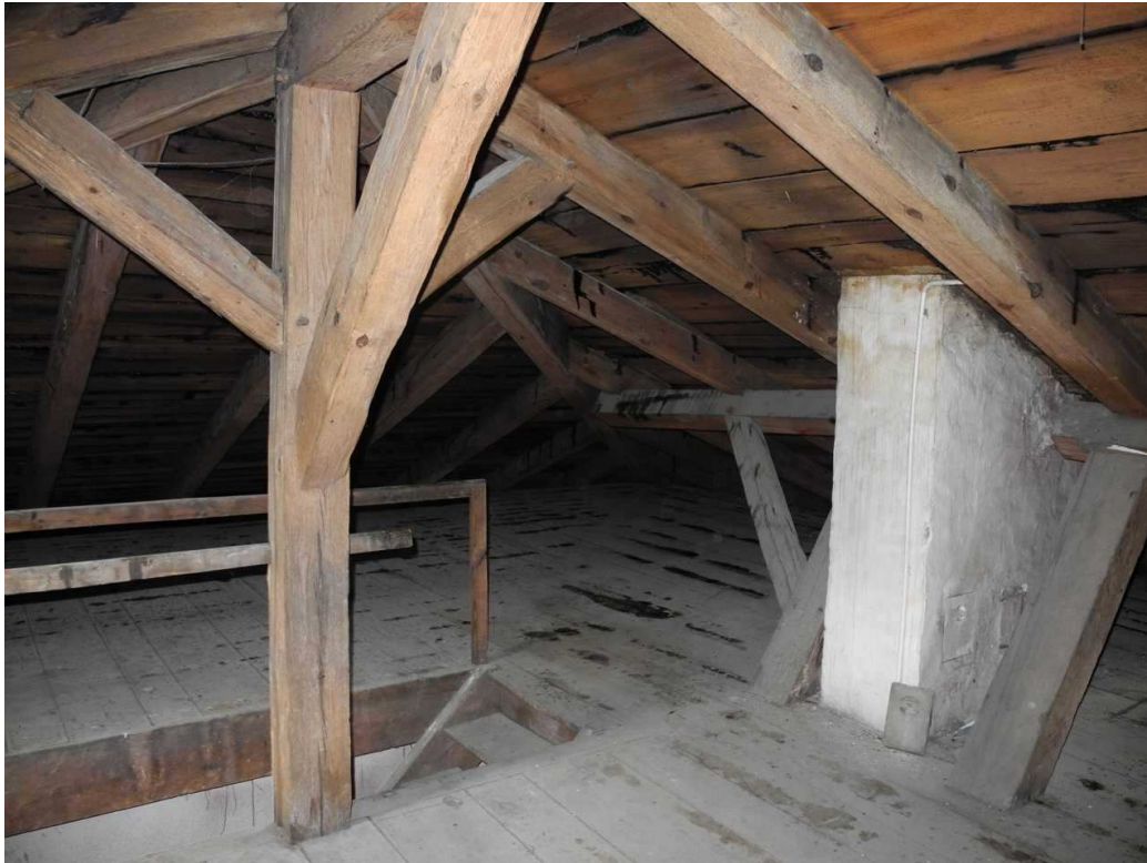
Fot. 17 strych poziom II
