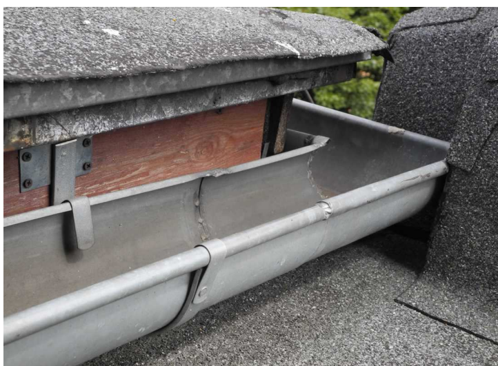
Fot.13, 14 Obróbka okapu, gzymsu, orynnowanie - szczegóły
