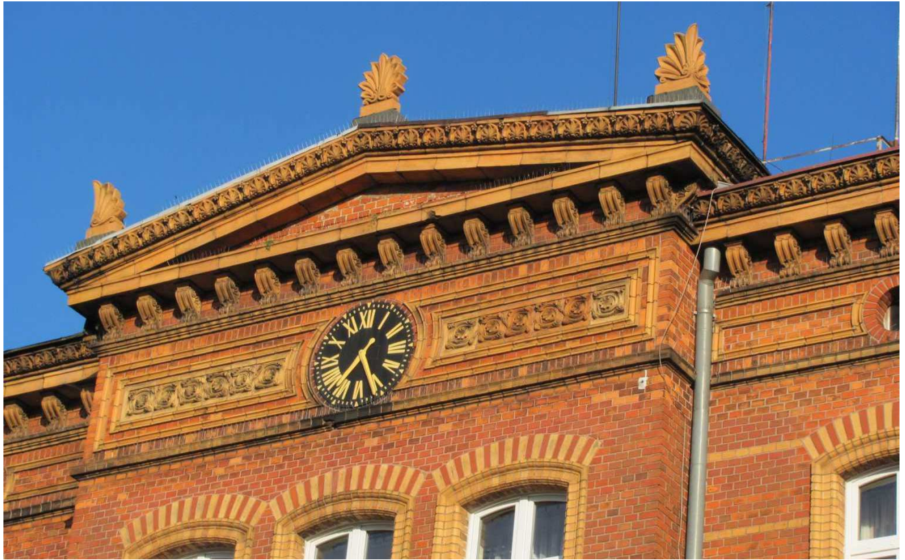
Fot. 3 elewacja frontowa - szczegóły
