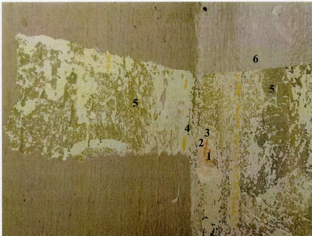
Fot.19 Odkrywka 8. wschodnia część ściany magistralnej nawy południowej z dekoracjami malarskimi w formie rozmalowanych kotar.
