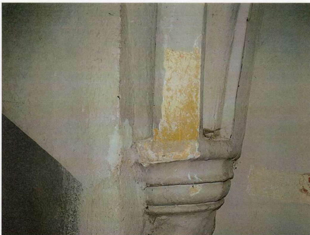
Fot.26 Odkrywka 14. Żebra sklepienne w kaplicy Bożywojów w odcieniu ugru z ciepłoszarą spoiną.
