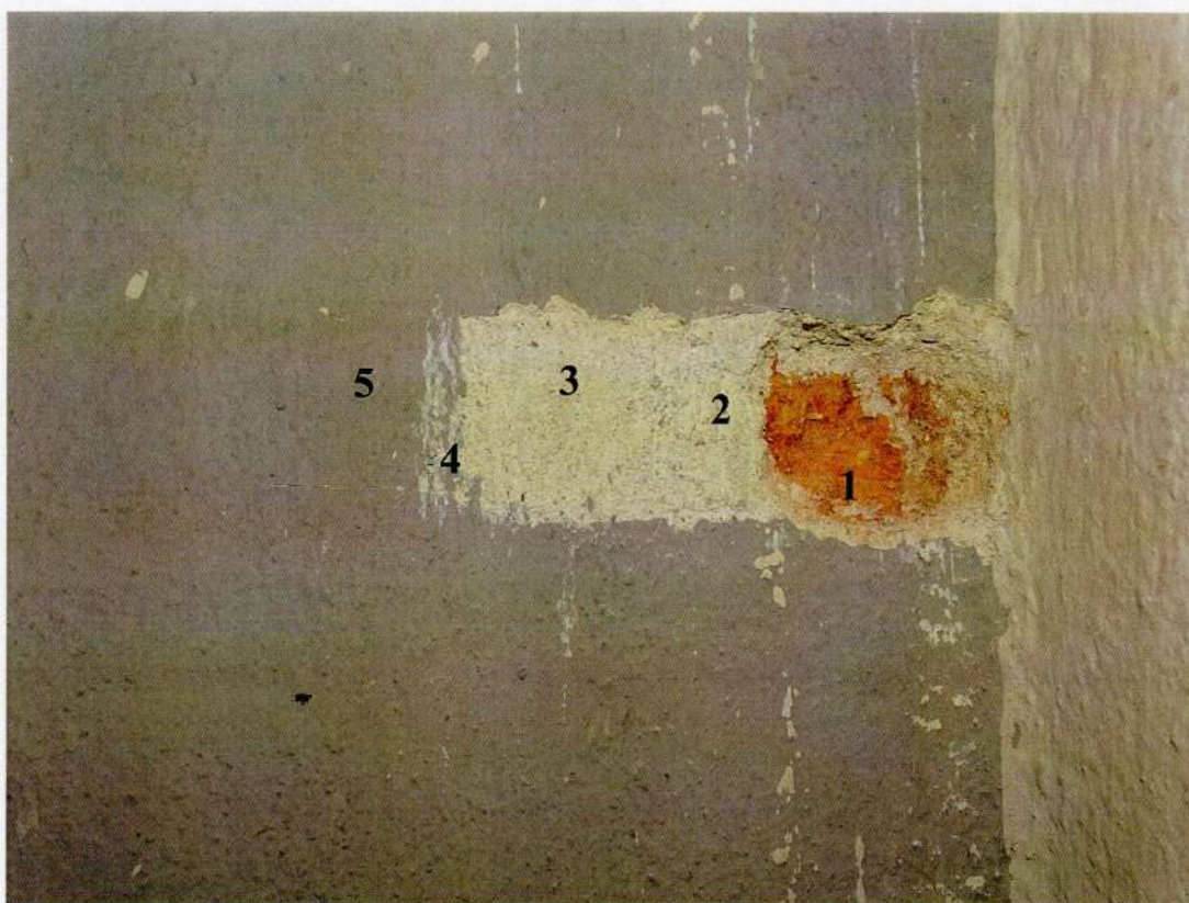
Fot.16 Odkrywka 5. Zachodnia część ściany magistralnej nawy południowej.
